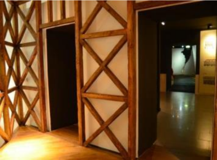
Núcleo XVI – Reconstruir a cidade. Lisboa Story Centre. Segmento de estrutura gaiola.
