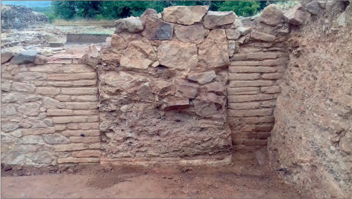
Fig. 14. Porta da taberna do forum , abrindo a Poente, para o kardo , com o vão moldurado em material laterício. Em momento difícil de precisar, o vão foi encerrado com blocos de quartzite, talvez na sequência da remodelação das paredes exteriores do complexo forense.
