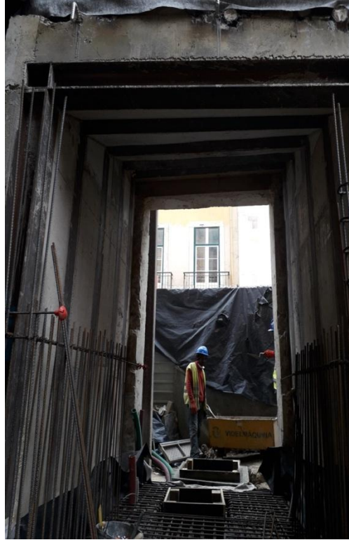
Foto 2 – Alçado do muro de contenção/claustro
