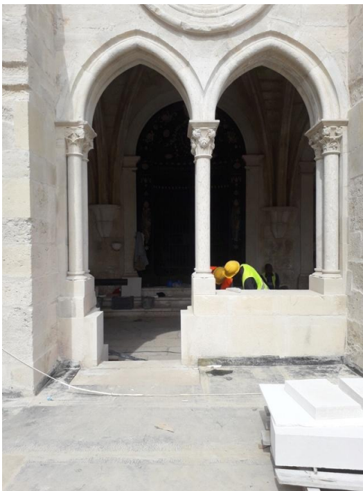
Fotos 3 e 4 – Corte de cantaria para abertura de um novo acesso entre o corredor do deambulatório e o espaço exterior do claustro
