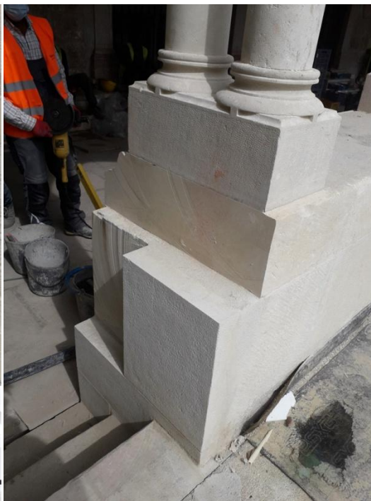
Fotos 3 e 4 – Corte de cantaria para abertura de um novo acesso entre o corredor do deambulatório e o espaço exterior do claustro
