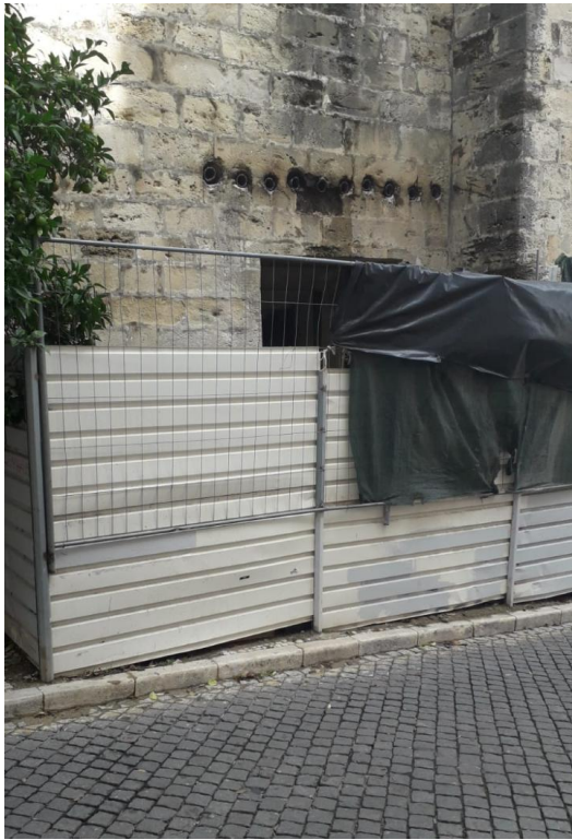
Foto 1- Alçado do muro de contenção/ Cruzes da Sé
