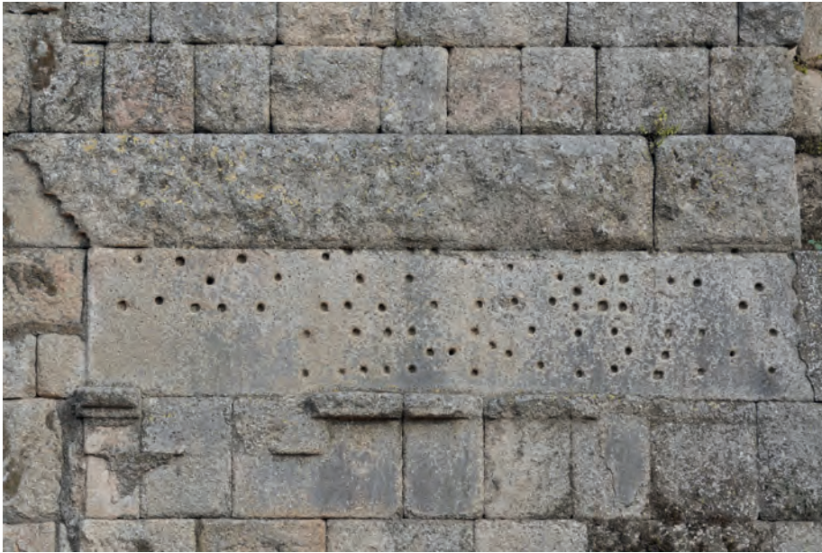
Fig. 2 a: Detalle del soporte de inscripción Cat. n.º 1 (foto Ángel Ventura); b: dibujo de los orificios para anclaje de letras metálicas en inscripción Cat. n.º 1 (foto y dibujo: S. Sánchez y Á. Ventura).
