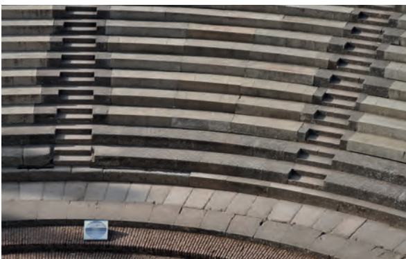
Fig. 33: Idem, vista aérea donde se aprecian las gradas originales y los canales para inserción de pluteus en el frente y en paralelo a la scalaria (foto: Á. Ventura).
