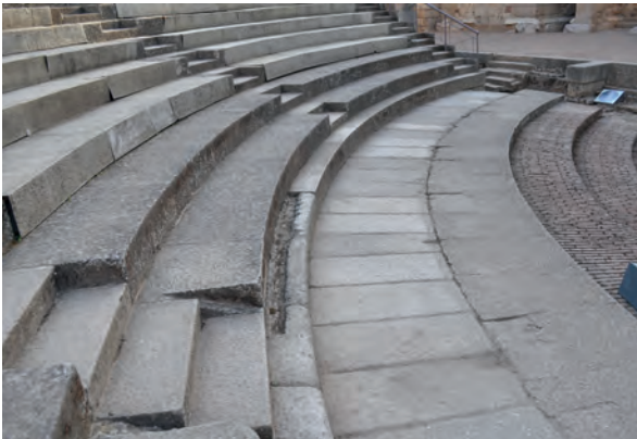
Fig. 32: Detalle del canal para insertar pluteus en la 1.ª grada de ese cuneus (foto: Á. Ventura).
