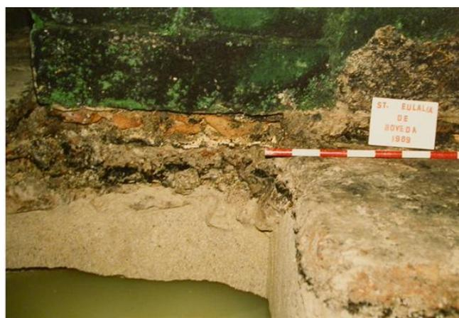
Fig. 182: Fotografías también de la Zona I en las que se aprecia la escasa cimentación dispuesta sobre un potente suelo natural de jabre. La de la izquierda se corresponde con la esquina SO del sondeo 11 y la derecha con el sondeo 9. En ésta se aprecia el tipo de suelo sobre el que descansa las losas de granito.
