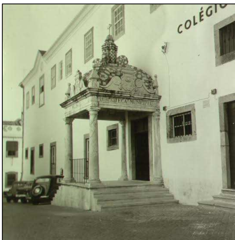
Figura 2 - Lateral da fachada da Biblioteca-Museu de Elvas. Fonte: Acervo da Biblioteca Municipal de Elvas Dra. Elsa Grilo.
