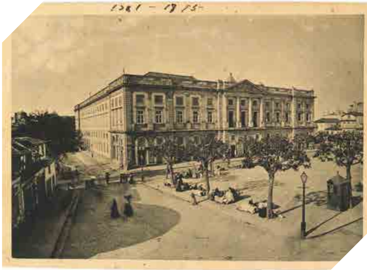
Vista da fachada principal e de uma das laterais do edifício da Academia Real da Marinha e Comércio (fotografia do século XIX)
