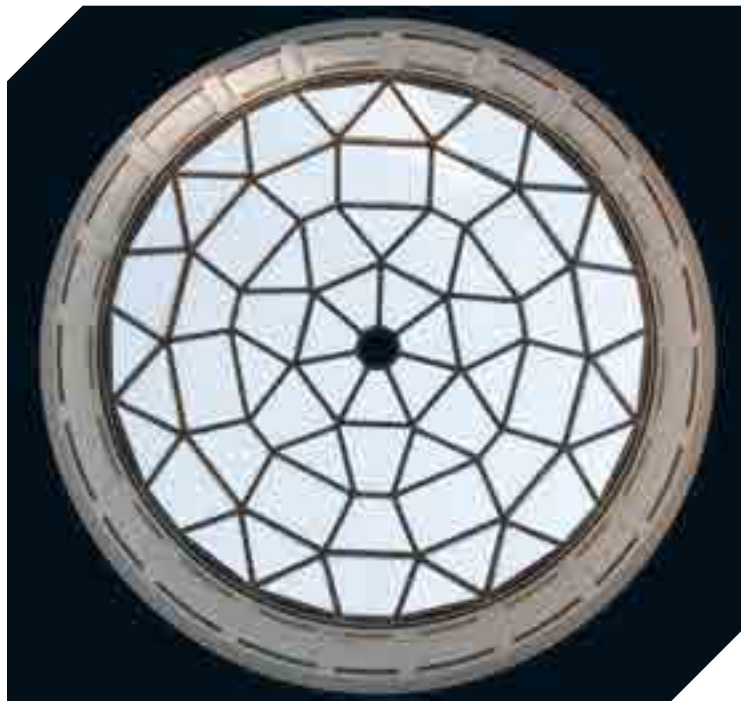
Clarabóia do edifício que atualmente alberga a Reitoria da Universidade do Porto
